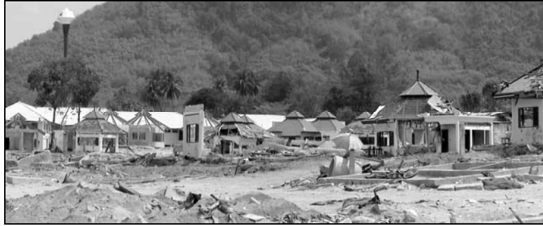
Abb. 4: Schäden an Gebäuden erlauben gute Rückschlüsse auf die Höhe der Tsunamiwelle (Beispiel von Khao Lak im Norden Thailands, hier mit 12 m ü.M.).
